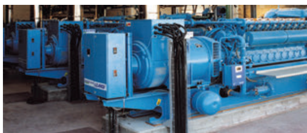
Виброизоляция генератора с помощью Vibrofix Block
